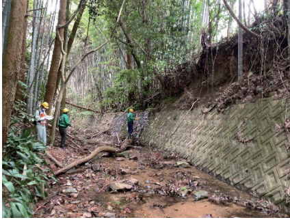
斜面地調査 鳳土木事務所管内
