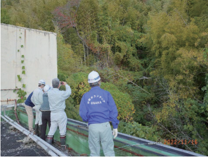
急傾斜地調査 枚方土木事務所管内
