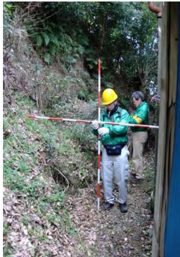
斜面状況の調査
