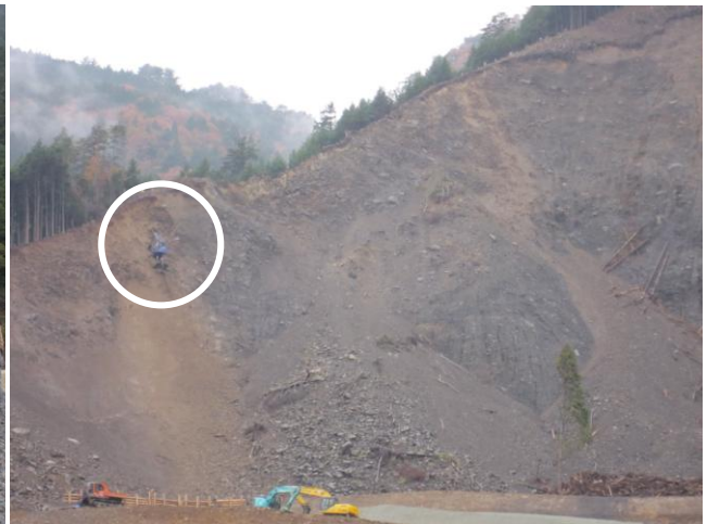
斜面左上部の遠隔操作による無人化施工
