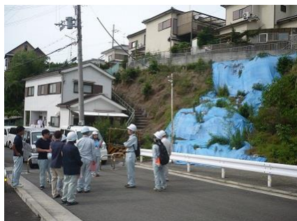
土砂災害パトロール (岸和田土木管内 貝塚市名越地区)
