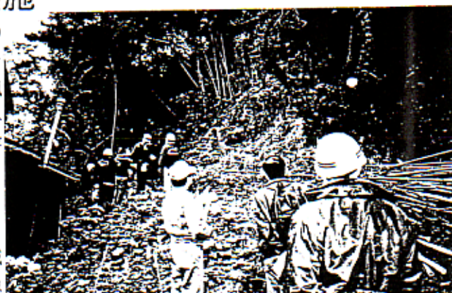
高槻市神内(1)地区急傾斜地点検状況
