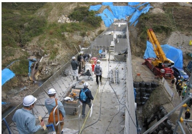
直轄施工による室生口砂防堰堤工事現場
