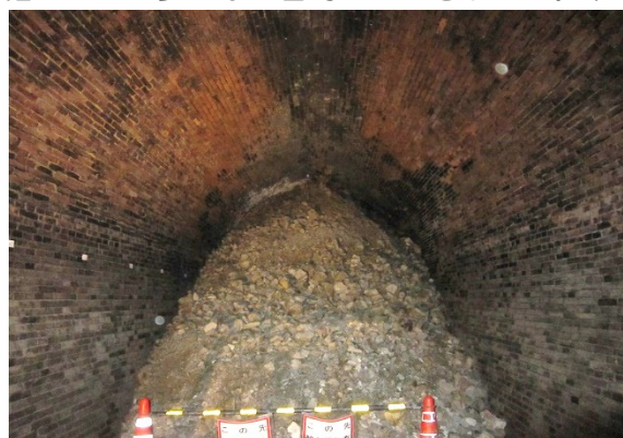
地すべりにより破壊された旧大阪鉄道亀瀬隧道
