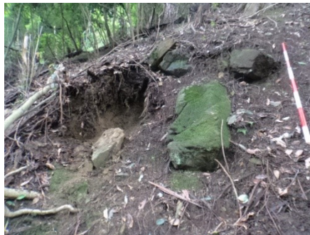
滝道斜面上部の落石発生箇所
