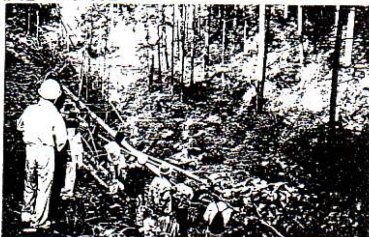
河内長野市天見地内での点検状況
