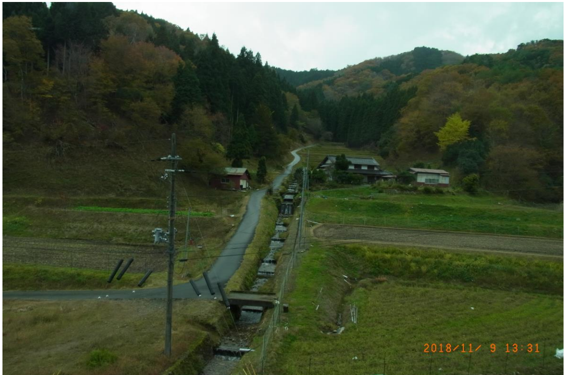
島瀬谷川流路工
