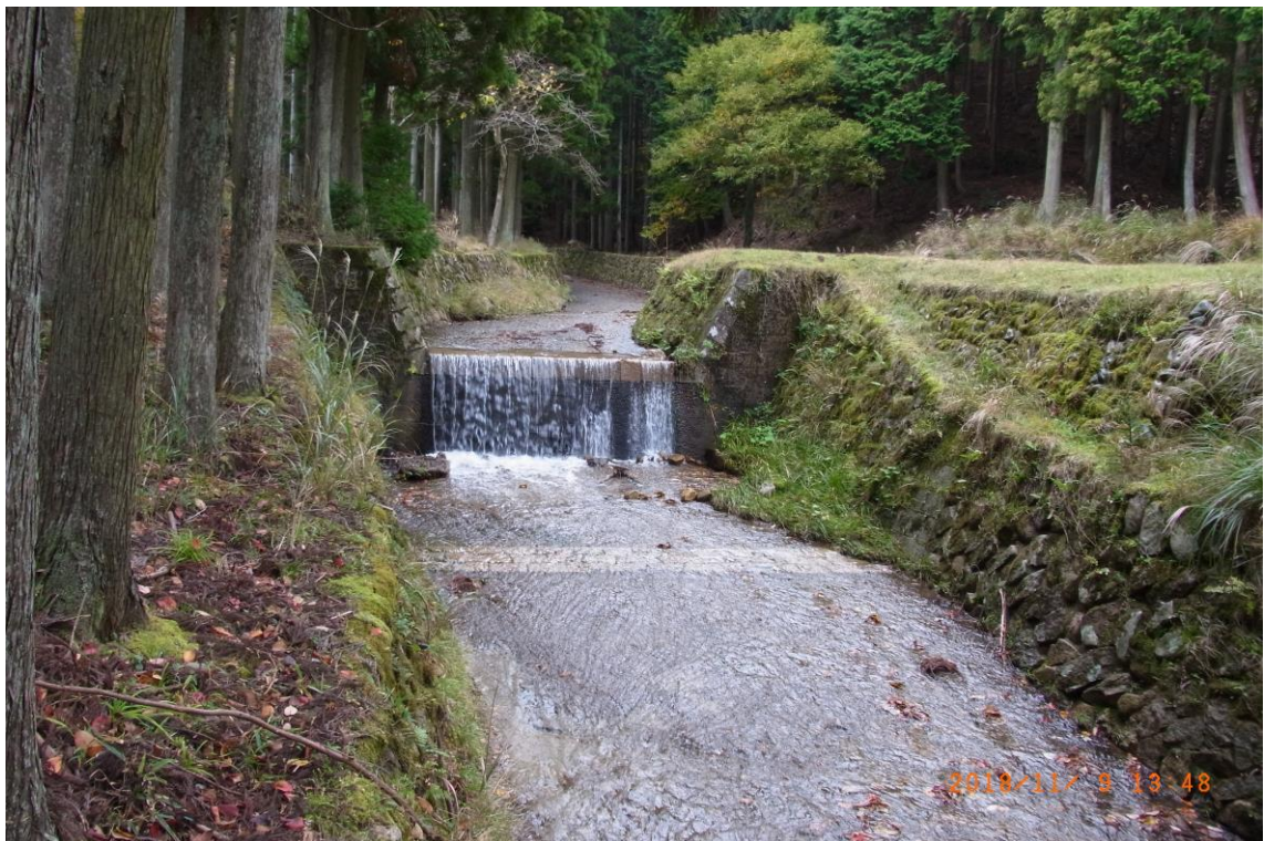
深山川流路工
