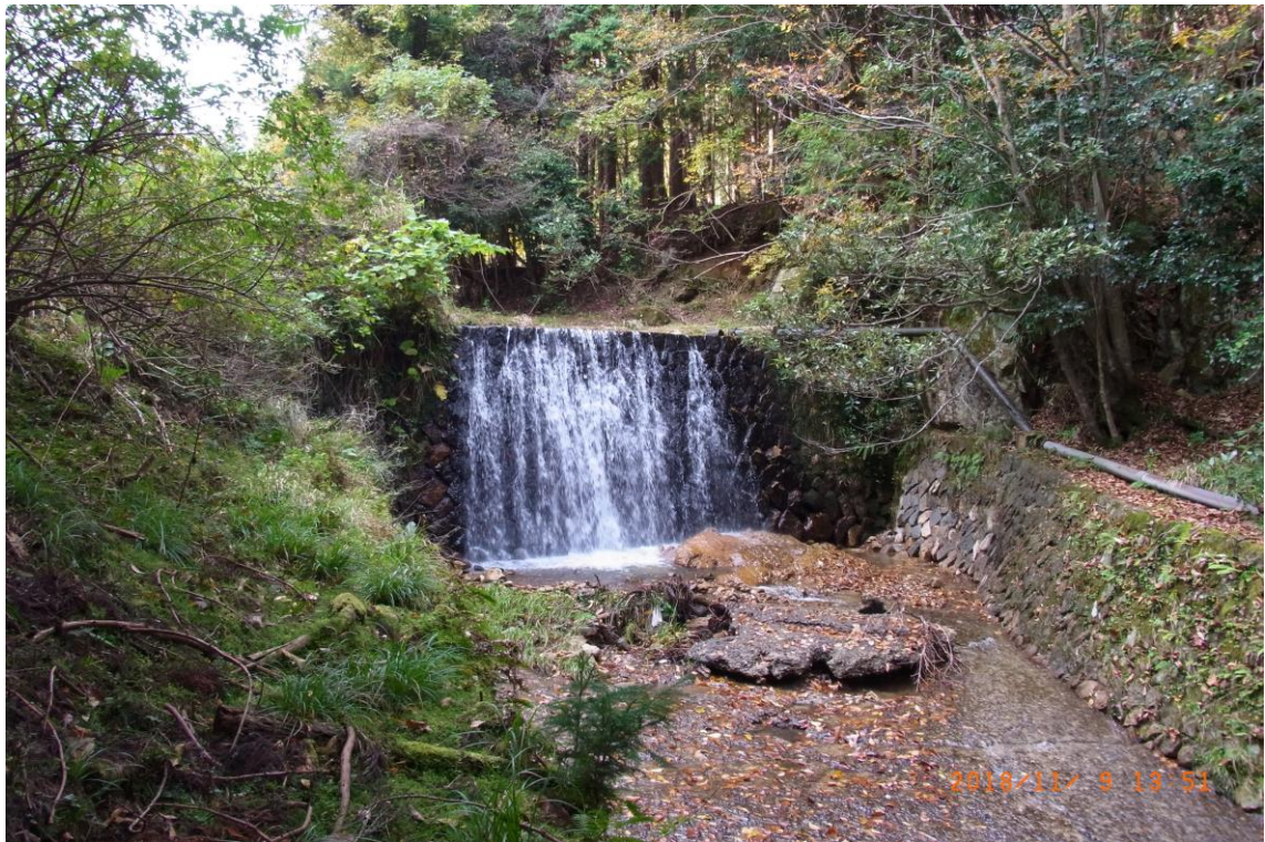
深山川第1号堰堤
