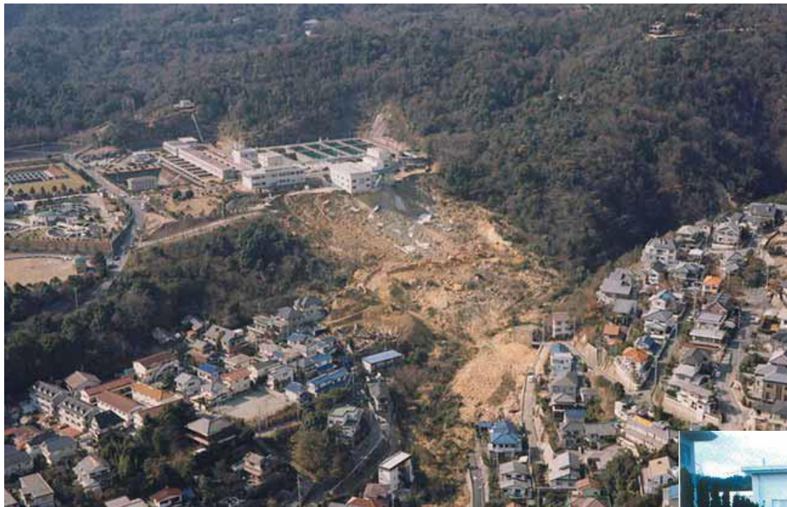
西宮市仁川百合野町地区 地すべり
