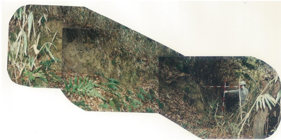
②地すべり冠頭部滑落崖の状況 昭和62年対策工事完成後拡大はみられない
